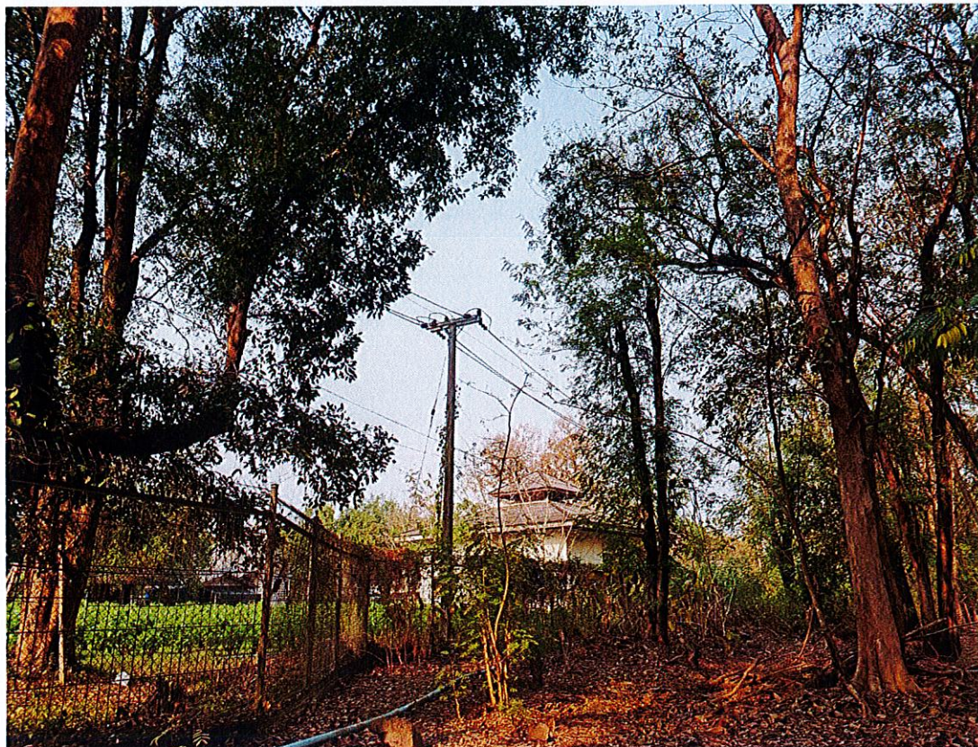
งานตัดต้นไม้ใกล้แนวสายไฟฟ้าแรงสูง ช่วงริมรั้วทางเข้าถึงลานจอดรถที่ ๓
